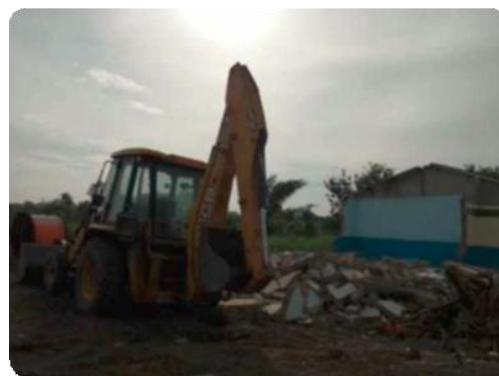
Vue de la destruction des obstacles dans le couloir de la ligne boucle OMGV
