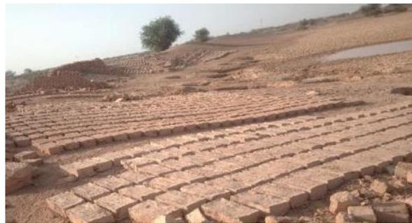
Des briques en banco fabriqués sur le site du projet à l'aide de la retenue d'eau du bouli / Coordonnées : x : 13°06'22,53" Y : 00°57'38,19"
